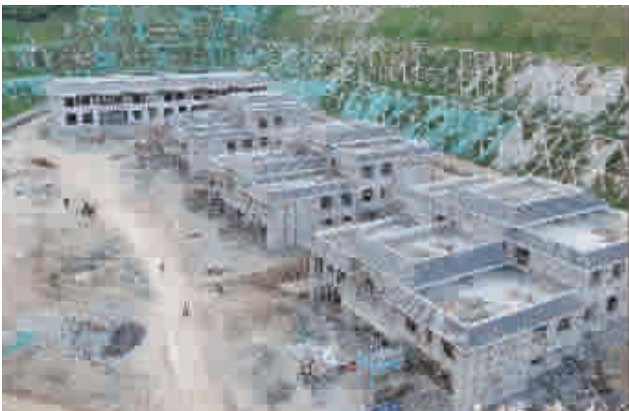
市殡仪服务中心部分建筑已完成主体建设。
