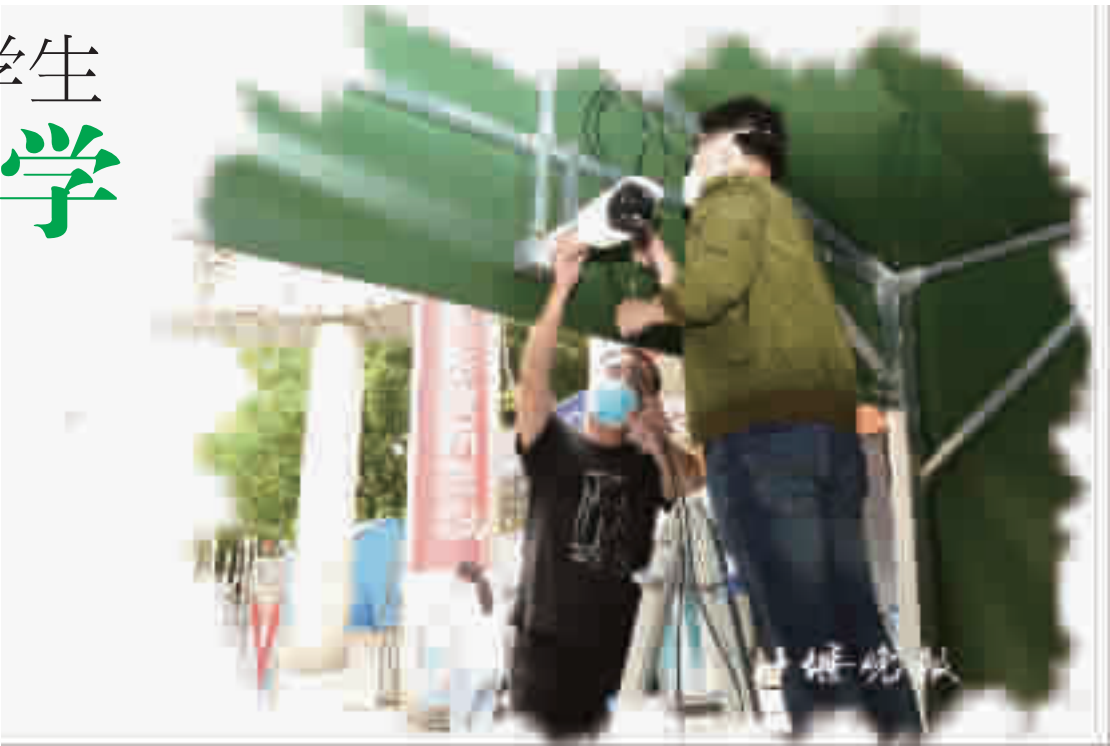
5月5日,市一中在做高三学生复课前的最后准备,为临时安检通道安装监控。
