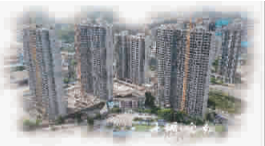
常隆花园建设项目一期 5 个楼栋全部封顶。
