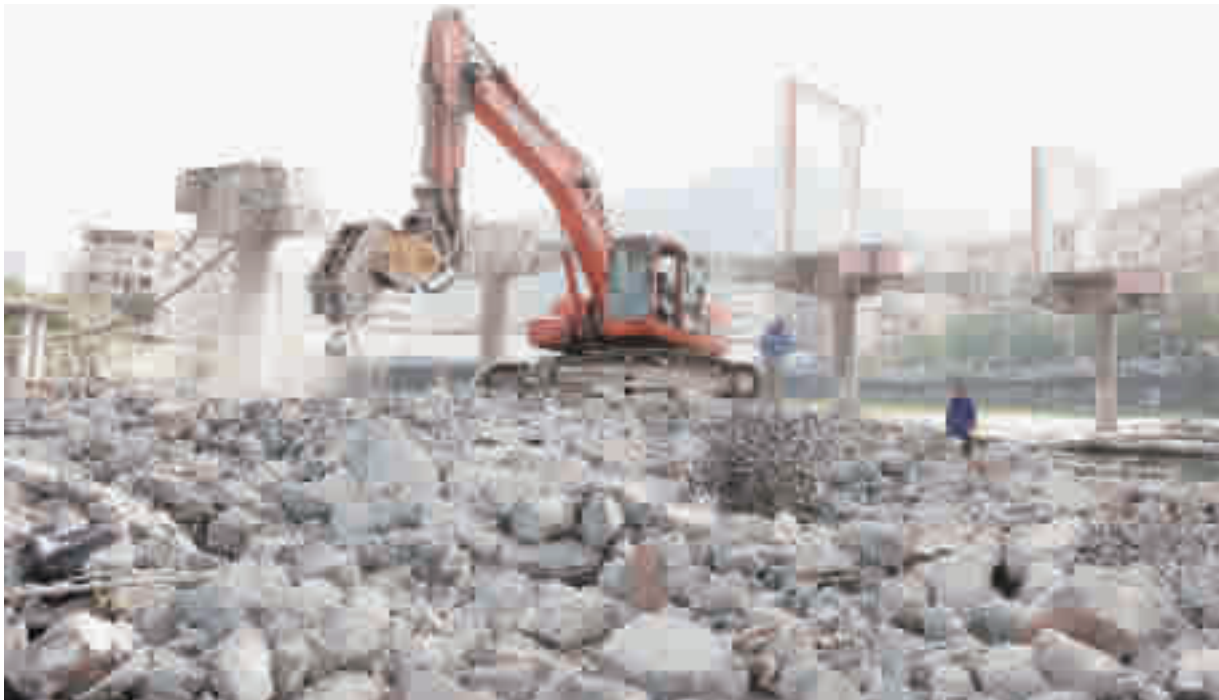
昨日,在百二河生态修复工程六堰段,原有的白帆桥正在拆除中。连日来,记者在百二河生态修复工程施工现场看到,河道沿线机器轰鸣、热火朝天,河道综合管沟基坑开挖、旧桥拆除等施工正有序推进。 图/记者 张启国
