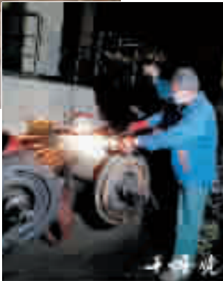
污水处理厂紧急组织 人员抢修故障设备。
