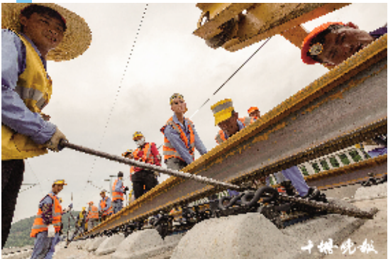
施工人员进行铺设高铁轨道。(拍摄于2019年5月30日)
