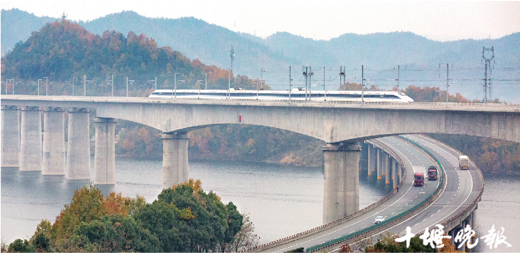
2019年11月29日12时19分,武汉至十堰高铁驶过浪河特大桥。
