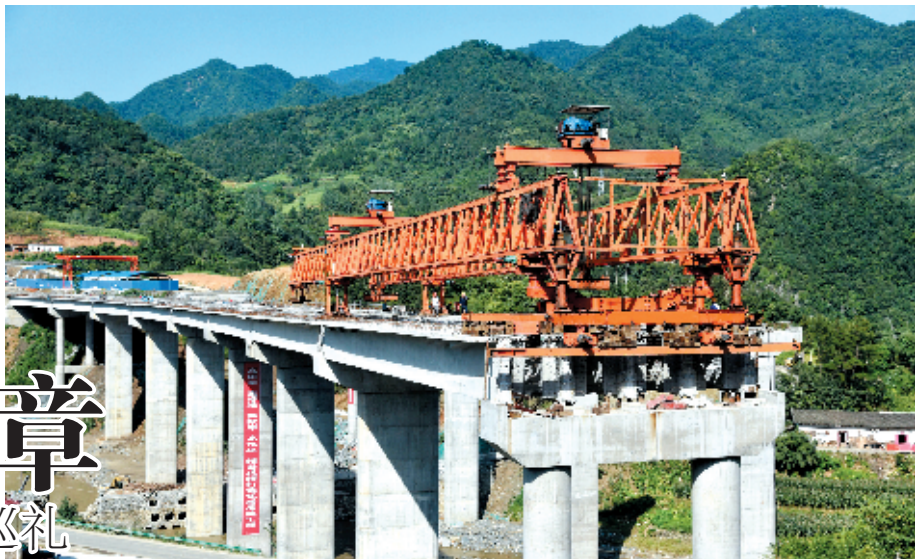
十巫高速建设现场。
