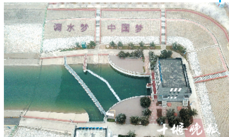
北拒马河暗渠节制闸是南水北调中线工程进京明渠转暗管的分界点。
