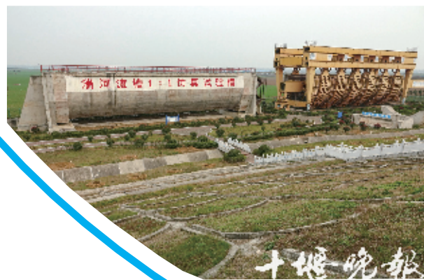
施工方特意留下一台造槽机和一跨湍河渡槽1:1仿真试验槽,用于今后建设湍河渡槽工程主题公园。
