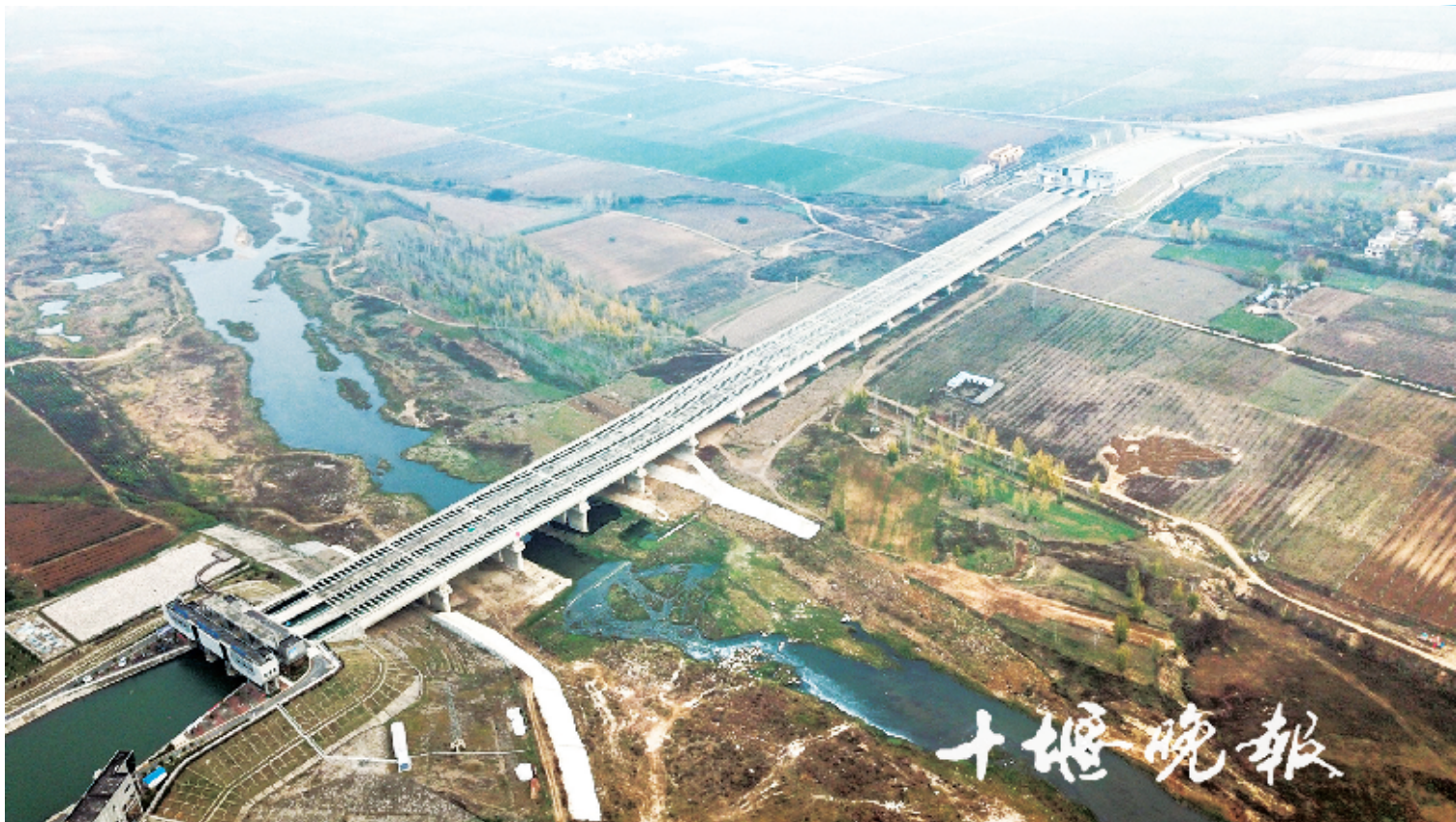
湍河渡槽位于河南省邓州市十林镇张坡村和赵集镇冀寨村之间的湍河上,工程全长1030米,共18跨,单跨重量达1600吨。(2019年11月28日摄)
