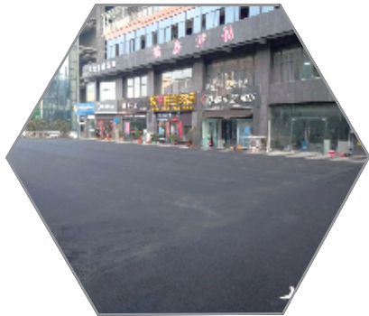
新修的沥青路面平整干净。
