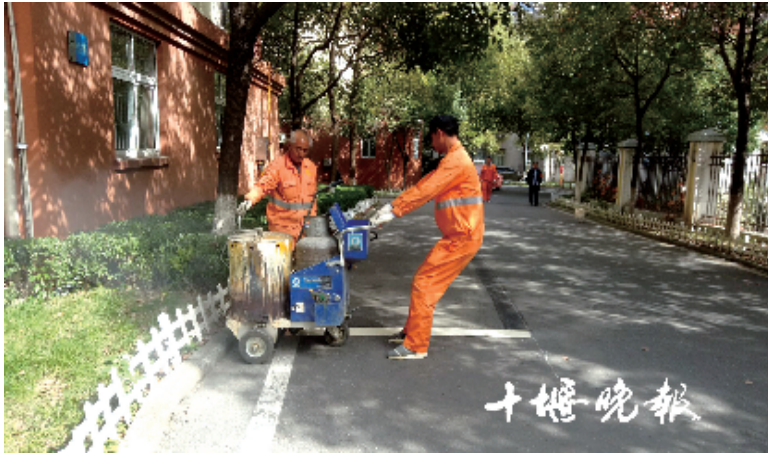
工作人员在世纪花园小区施划停车位。
