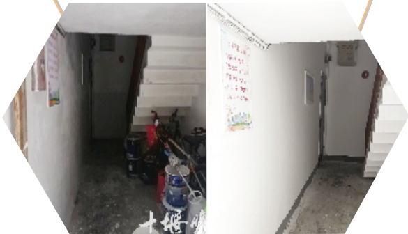
小区楼道整治前。 小区楼道整治后。
