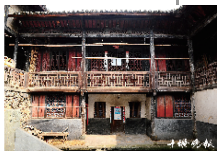
高家花屋院内正厅。
