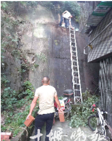
工人在修补渗水墙面。
