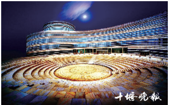
相继建设了太极剧场、武当山博物馆、武当武术国际交流中心、游客中心等配套设施。
