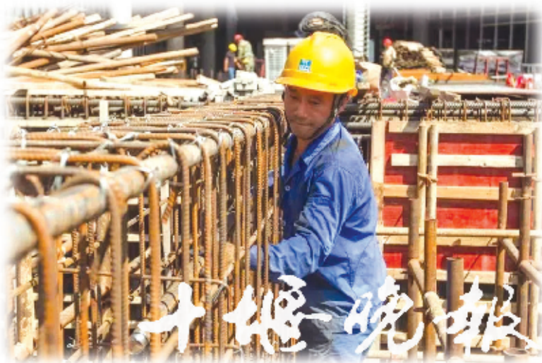
工人们紧张施工,积极推进十堰北站建成投用。
