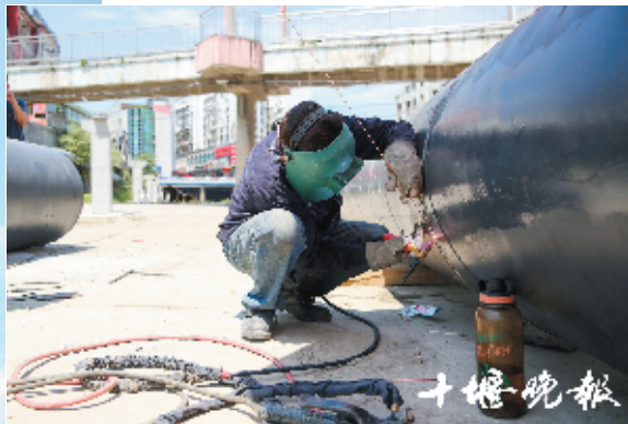
施工现场,超大号水杯是每个工人的标配。
