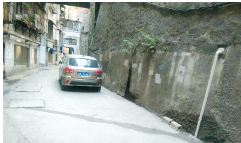
民爆家属楼渗水山体改造后,路面积水现象消失。
