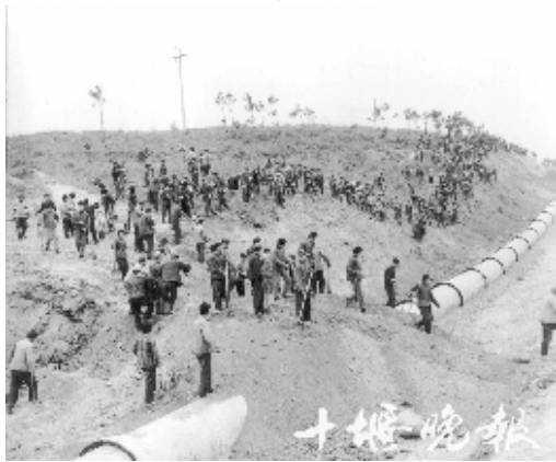
工人在修建黄龙至十堰城区的引水工程。
