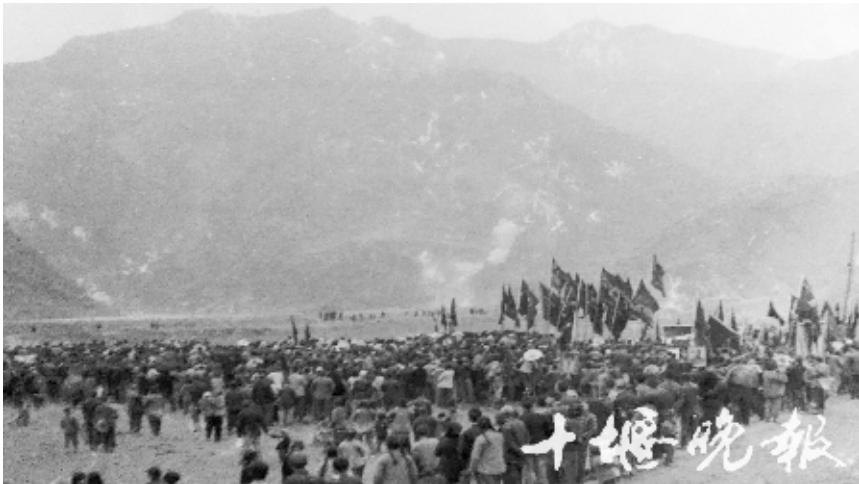
1969年4月2日,黄龙滩水电工程破土动工。
