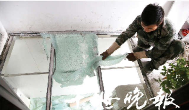
执法人员对违建进行拆除。
