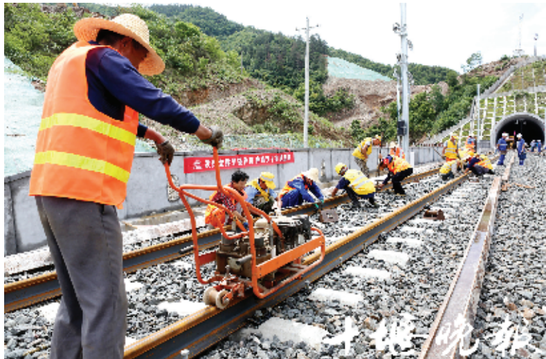
工人们正在对接汉十高铁进入十堰北站的铁轨。
