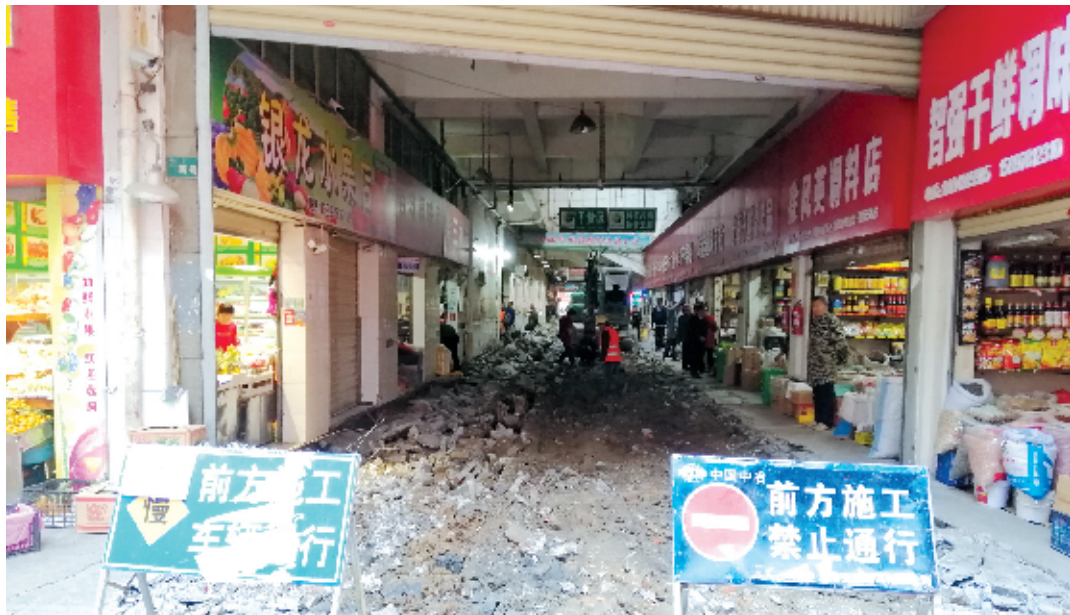
大型挖掘机在老虎沟市场消防通道内施工作业。
