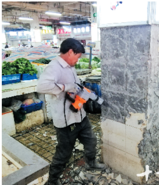
施工人员对老虎沟市场内墙面进行施工改造。
