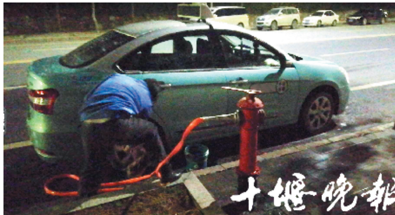
司机私自打开消防栓洗车。
