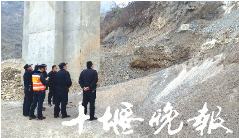
事发地的高速公路桥墩处及桥梁边坡处有大面积的挖掘的痕迹。
