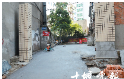
文汇小区门口的下坡路修整前后。
