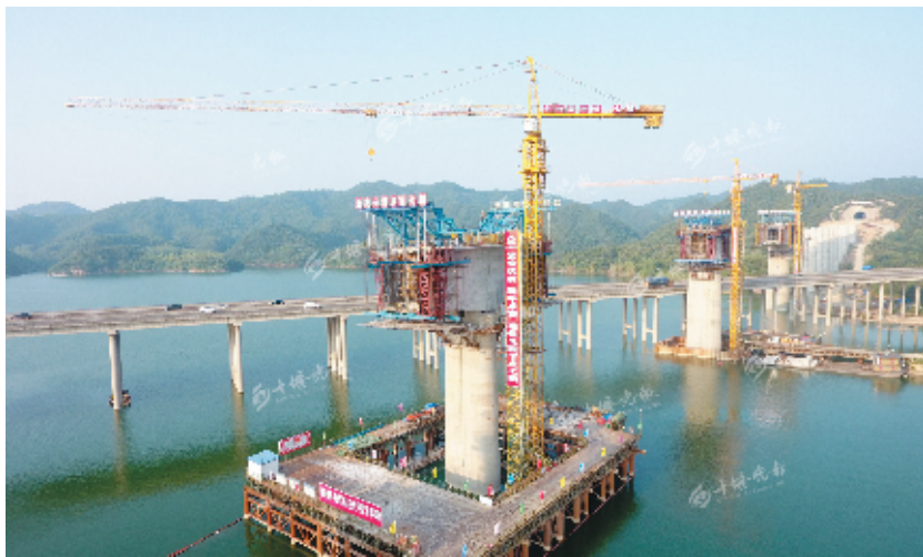
汉十高铁浪河特大桥建设现场(资料图片)。
