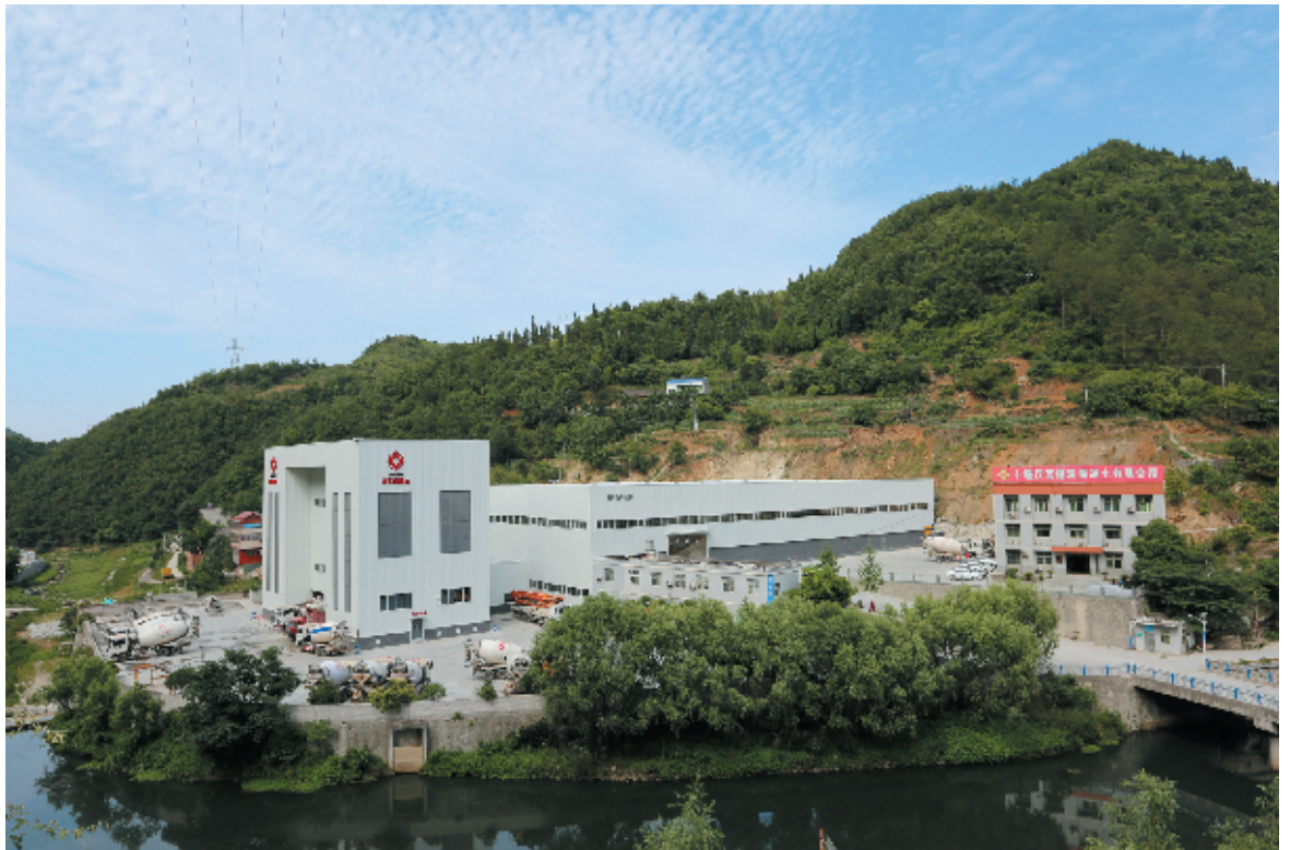
完成绿色改造后的混凝土搅拌站。
