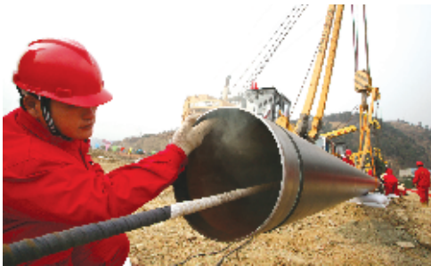
2011年11月18日，“西二线”东段襄阳—十堰支线2标段天然气管道全线贯通。图/记者 张建波
