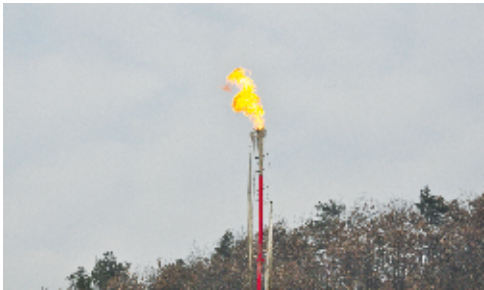
2011年11月27日，“西气东输”十堰天然气末站放空火炬点燃。图/记者 张建波
