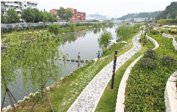
我市市政设施完好率达到99%以上，提升了市政设施的服务功能。 图/记者 张建波
