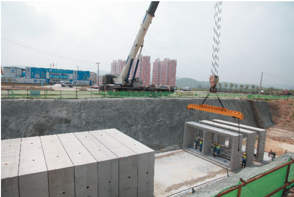
沧浪大道地下管廊建设。
