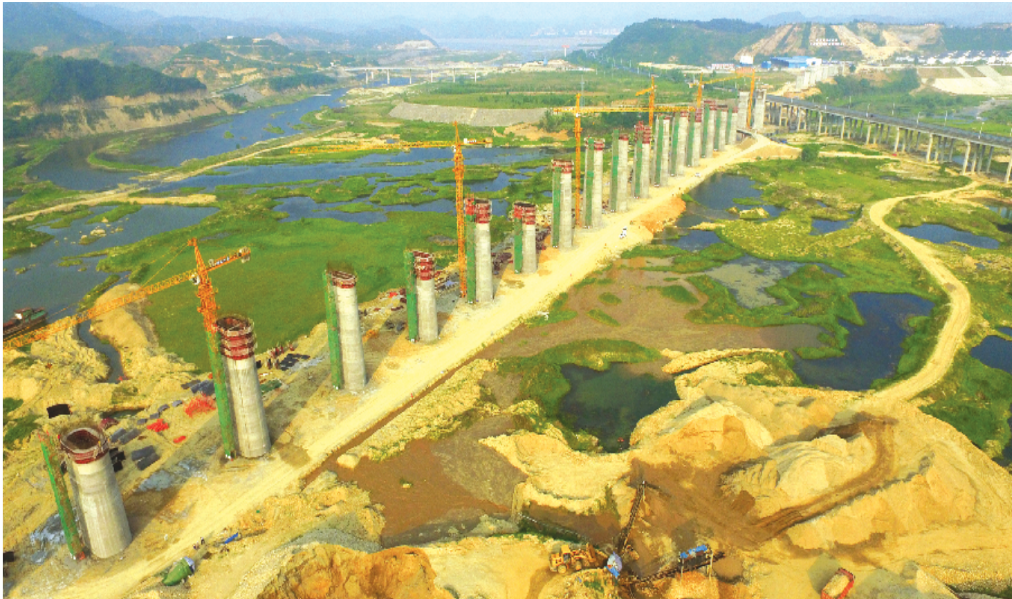
目前,跨越汉十高速公路的汉十高铁官山特大桥已完成桥墩施工。图/记者 刘成臣
