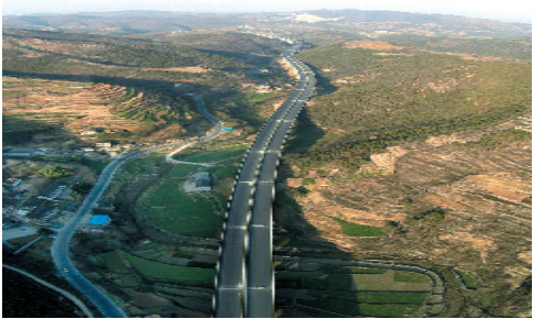
一条条高速公路宛如巨龙般穿行在群山之间。
