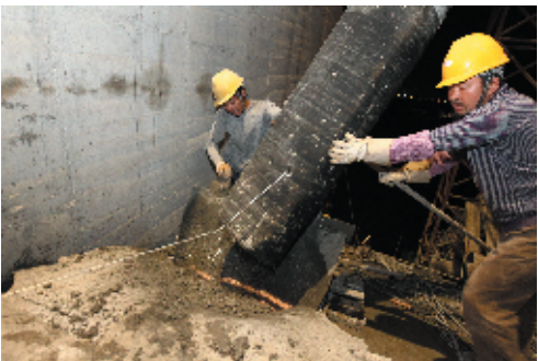
每一仓混凝土都凝结着施工人员的汗水。
