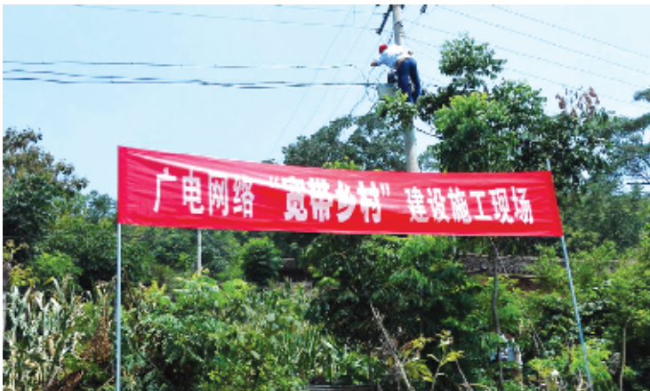
广电宽带乡村建设施工现场。
