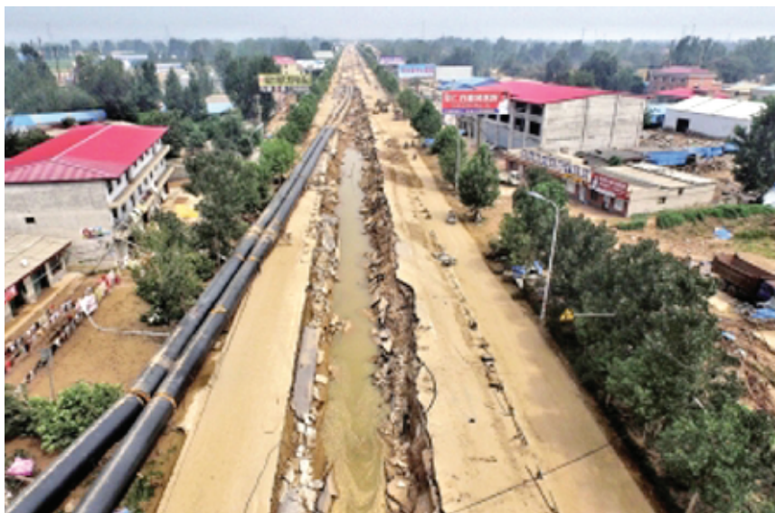
洪水将坑内的管道冲到路边。
