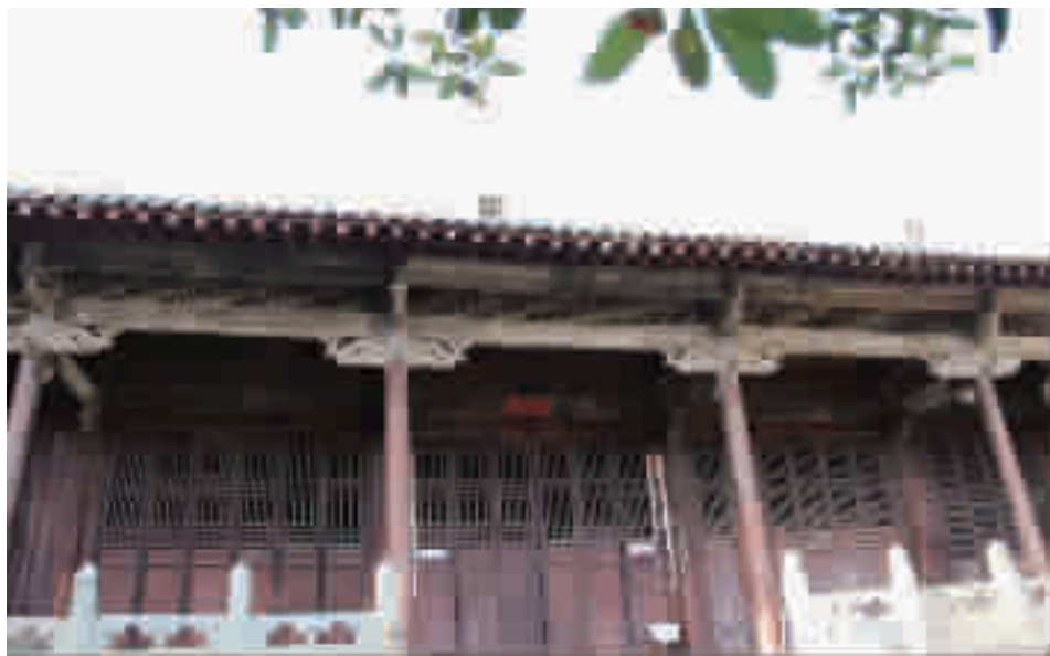
冲虚庵祖师殿有唐朝建筑风格。
