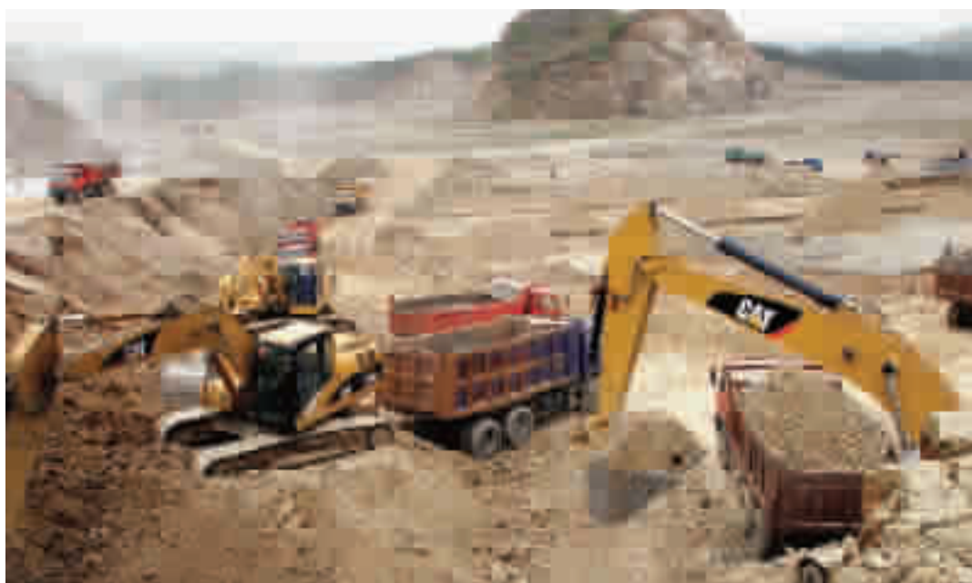
为了寻求发展空间,十堰向山“开战”,削峰填谷,挖山填沟,连片开发,这就是万亩山地整理项目。这些诞生在挖掘机下的平地,被人们形象地称为“人造平原”。
