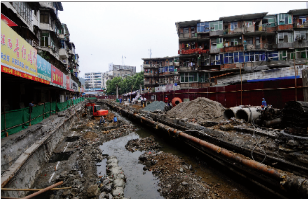
上海路改造正在进行中。
