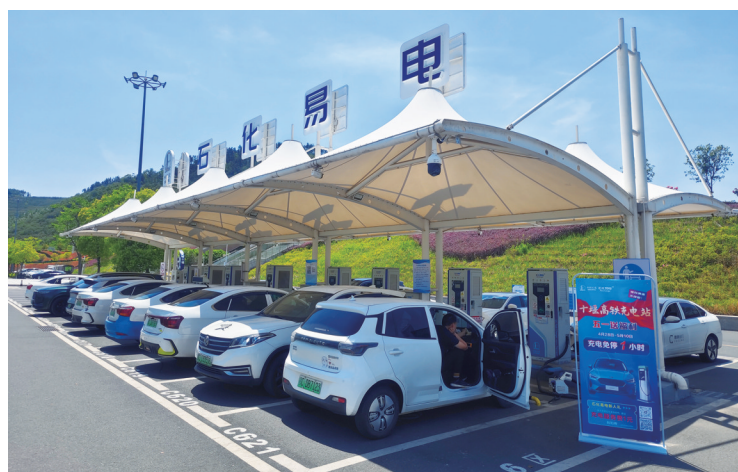
「石化易电」十堰高铁充电站为新能源车提供服务。
