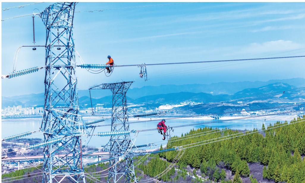
十堰松石至大堰220千伏输电线路工程完工，西十高铁湖北段“电力大动脉”打通。
