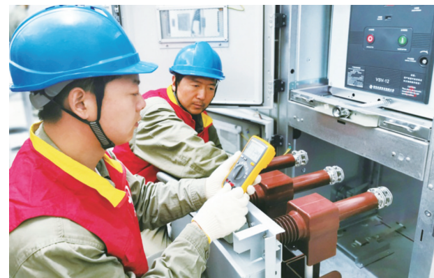
十堰巨能电力集团“南水北调”共产党员服务队检修用户设备。
