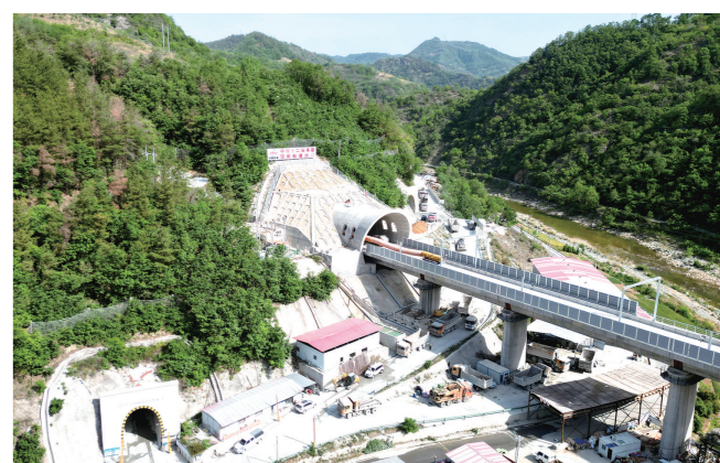
6月15日,西十高铁湖北段全线重点控制性工程岭隧道、郧西隧道同日顺利贯通。图/记者 刘昆
