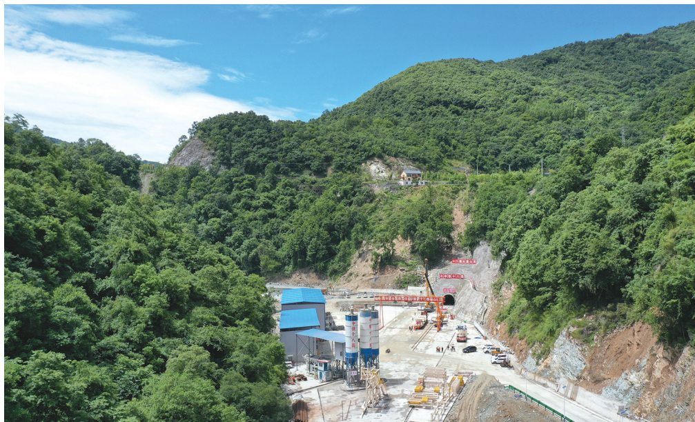
百二河隧道隧洞掘进施工现场。
