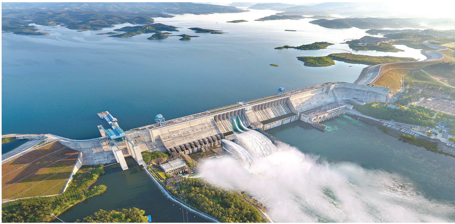
丹江口大坝。图/记者 张建波
