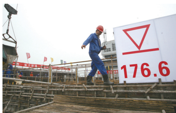
2009年6月20日,丹江口大坝需加高的54个混凝土坝段坝顶全线达到176.6米。图/记者 张建波
