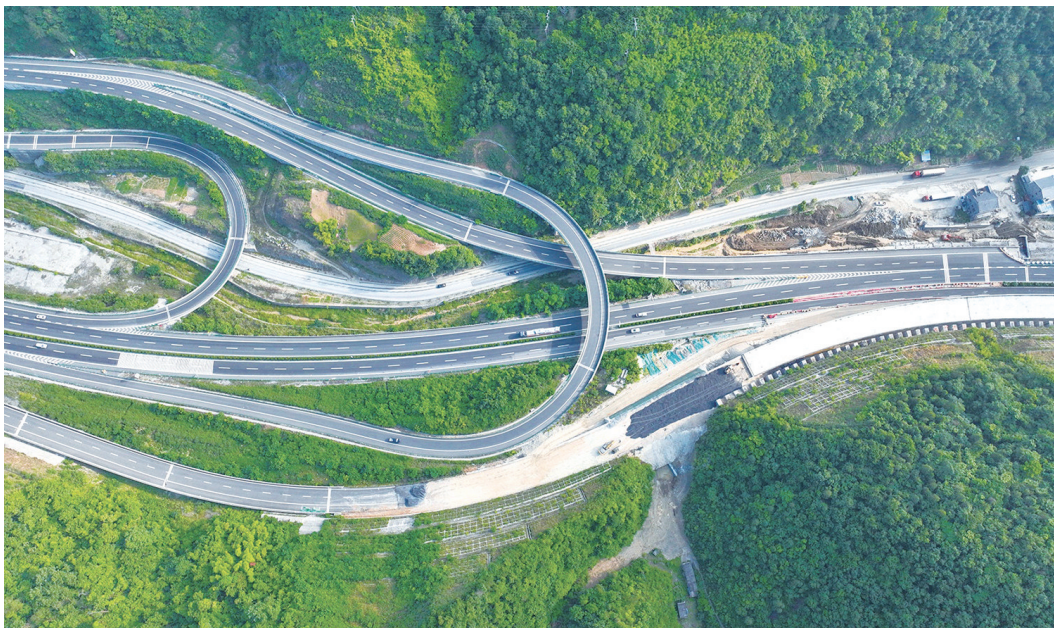
十巫北高速公路鲍峡枢纽互通项目施工现场。(资料图)
