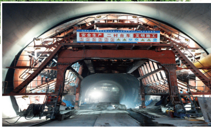
园岭隧道施工正酣。
