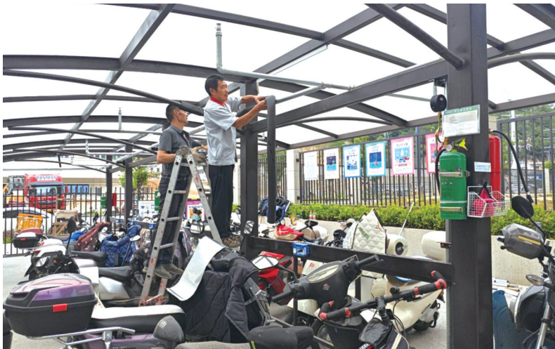
施工人员在充电车棚顶部安装喷头。
