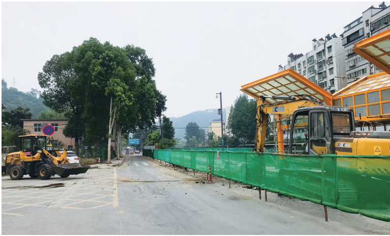
马家河路半幅施工,提醒过往车辆减速慢行。
