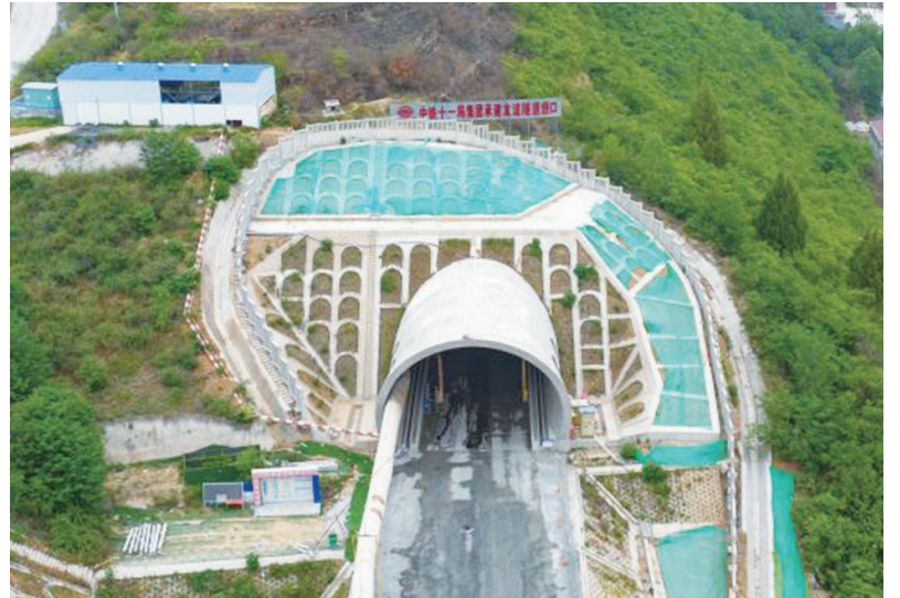
5月13日,西十高铁友谊隧道顺利贯通。(图片由受访单位提供)
