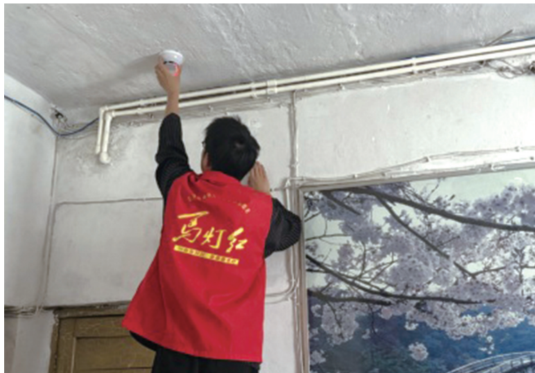
一名网格员将烟感器拆卸下来检查。
