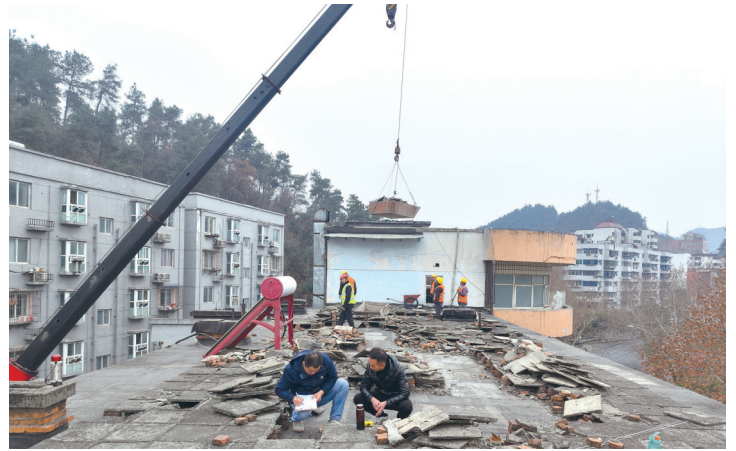
施工人员正在对楼顶进行改造。
